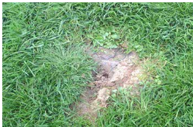
Photo 1 : trous dans la couche végétale
